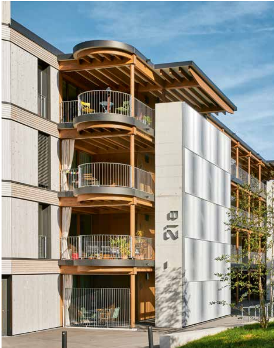
↑ Wohnüberbauung Waldacker in St. Gallen mit 110 Wohnungen: Erster Holzbau in der Schweiz mit der SNBS-Zertifizierung Level Platin. Quelle: Renggli AG
